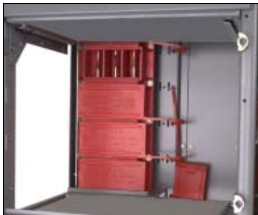
Figure 44 : Volet manuel de jeu de barres verticales
