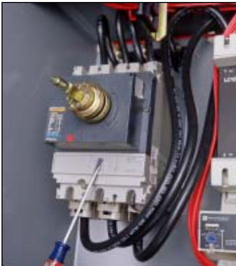
Figura 45: Ajuste del disparo magnético
