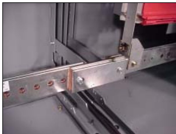
Figure 19 : Boulons de barre de mise à la terre remis en place
