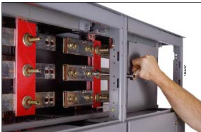
Figura 14: Desmontaje de los tornillos del conjunto de empalme
