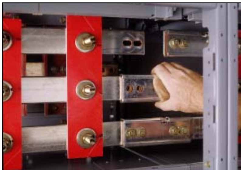
Figura 15: Alineación del empalme y las perforaciones del bus
