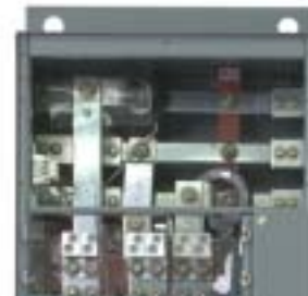
Figure 25 : Compartiment supérieur à cosses principales
