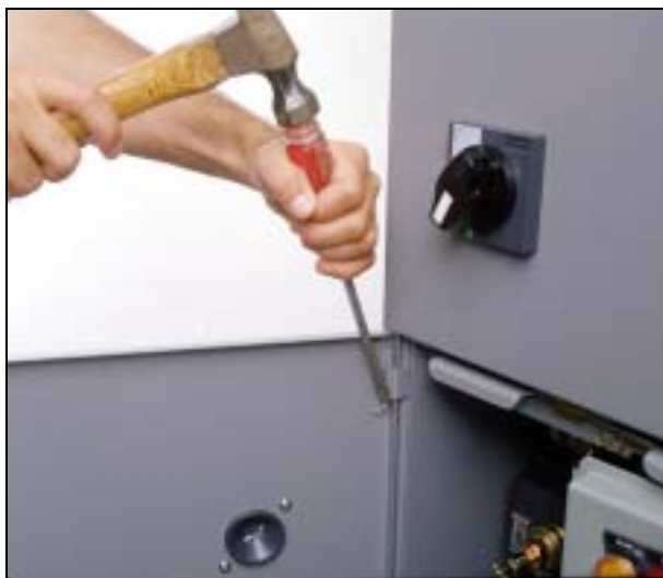
Figura 35: Extracción del pasador de bisagra
