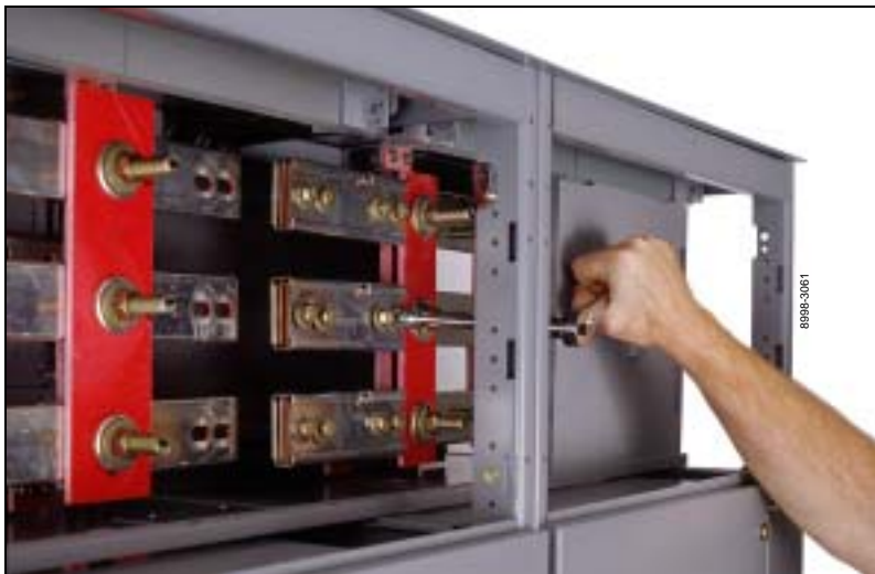
Figure 14 : Retrait des boulons de l'ensemble de raccordement
