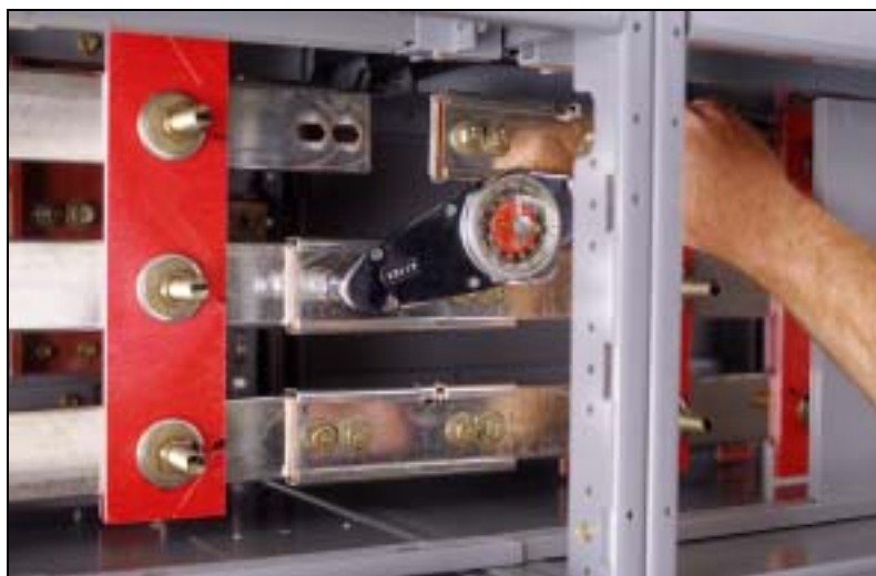
Figure 17 : Serrage des boulons
