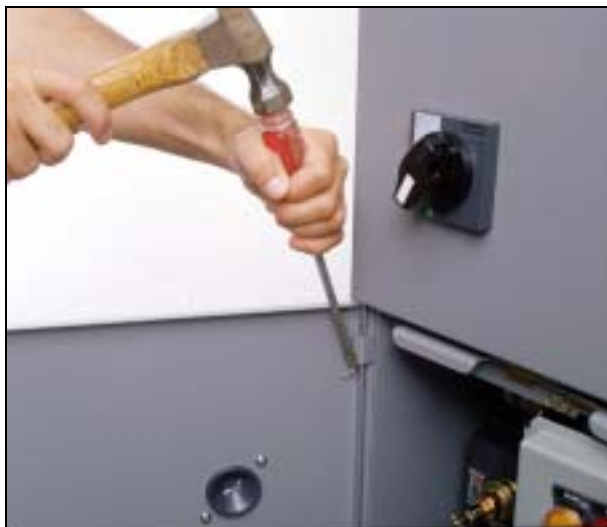
Figure 35 : Chasse de la broche d'une charnière
