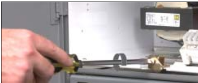
Figura 29: Liberación del dispositivo de bloqueo (cuando viene incluido)
