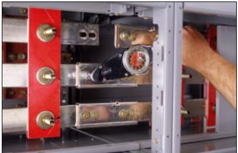
Figura 17: Apriete de los tornillos
