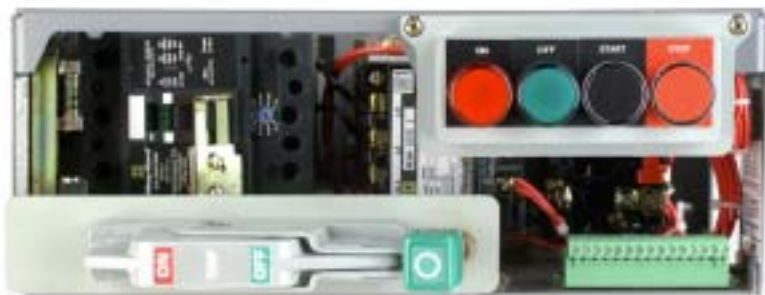
Figura 36: Palanca de funcionamiento en la posición “OFF” (O)
