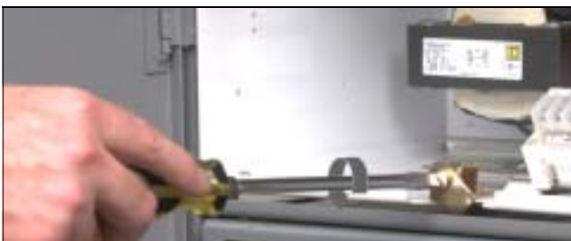
Figure 29 : Libération du dispositif de blocage (si présent)
