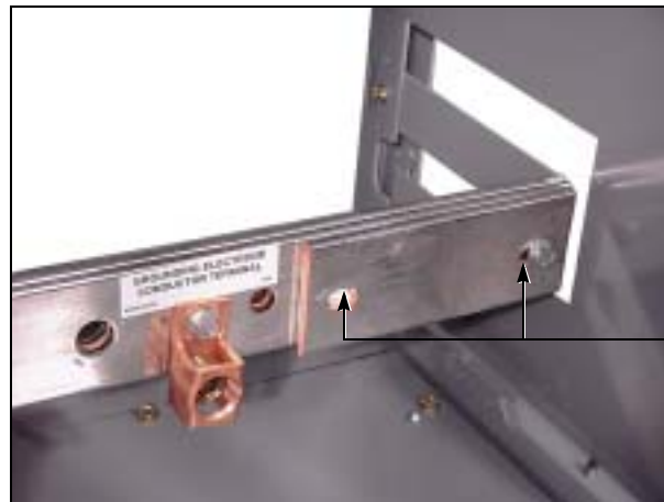
Figure 18 : Emplacement des boulons de la barre de mise à la terre
