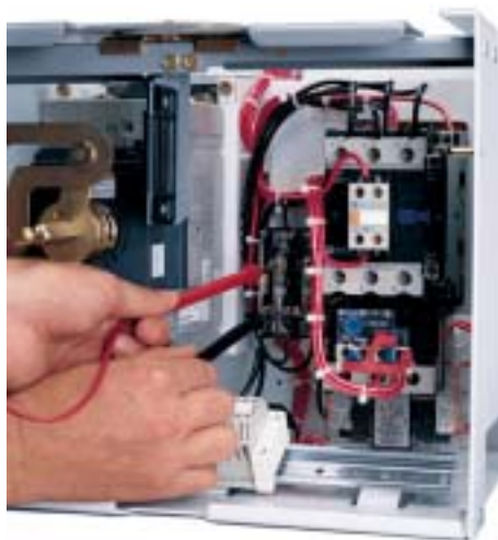
Figure 41 : Inspection des fusibles
