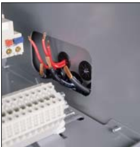
Figure 52 : Connexion de l'alimentation et des fils de commande
