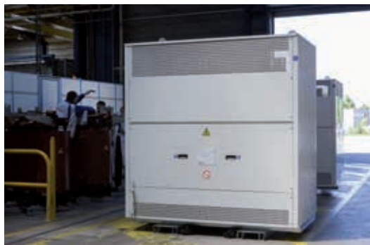
Envoltente de protección IP31, IK7
