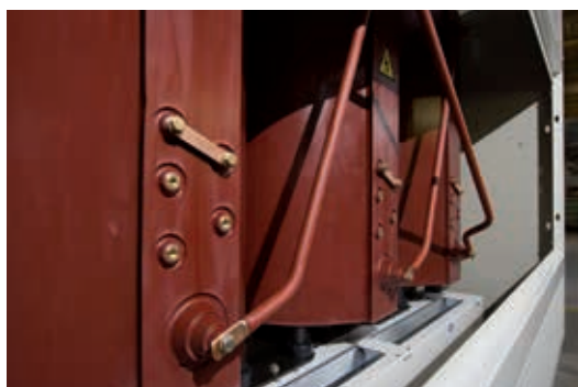
Transformador con ventilación forzada en envoltorio IP31
